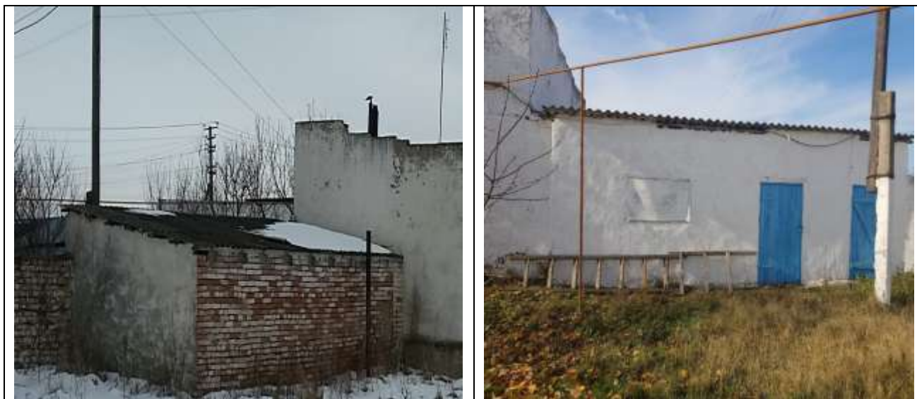
5. Токарный цех, помещения №5,6
